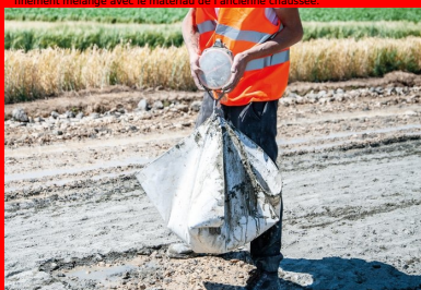
Contrôle de la régularité de l'épandage et de la quantité des liants réalisé par la méthode dite « à la bêche ».
