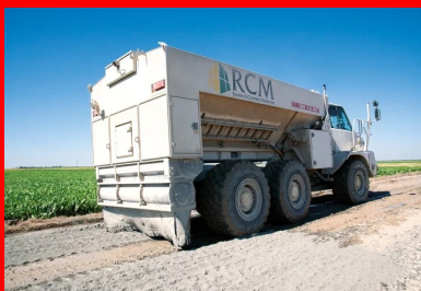
L'épandeur à liant de RCM.
