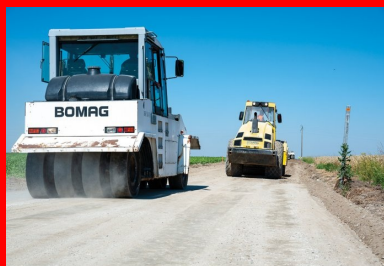
L'atelier de compactage composé d'un compacteur à pneumatiques Bomag BW 24 RH et d'un rouleau V5.
