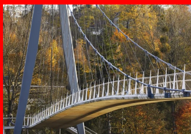
Le mât se confond dans la végétation.
