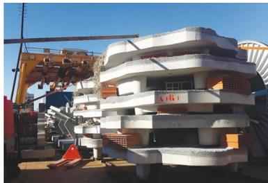
Dalles Rague en béton bicouche de Seabost, sur le quai, avant leur mise à l'eau dans la calanque de Cortiou.
