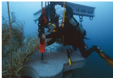
Plongeur en action : mise en place d'un récif Rague par moins 20 m.
