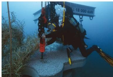
Plongeur en action : mise en place d'un récif Rague par moins 20 m.
