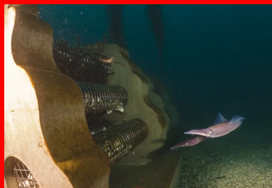
Calanque de Cortiou, le récif Connectivité (Seaboost) mettant en œuvre des dalles de béton PM et des pochons en métal remplis de coquilles et fibres naturelles.
