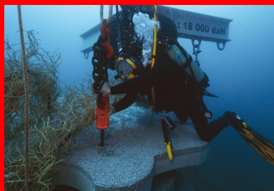
Plongeur en action : mise en place d'un récif Rague par moins 20 m.
