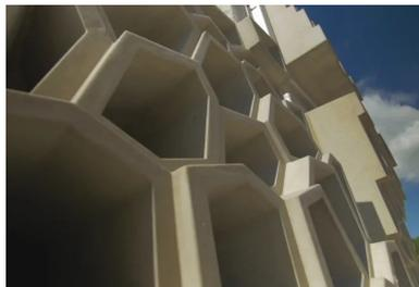
À la Réunion, le Panal®, « casier » alvéolé en CCV, conçu pour résister à une pression de plus de 10 tonnes par mètre carré.
