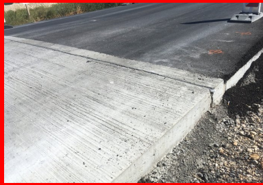
Une dalle de transition avant et après la mise en œuvre de l'enrobé.
