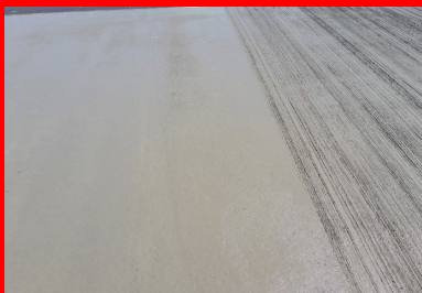
Les joints de retrait et le béton avec sa finition balayée.
