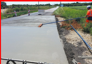
Après mise en place, le béton a été balayé pour l'adhérence et la tenue de route des véhicules.
