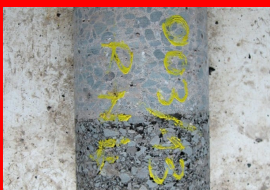
Carotte prélevée illustrant un collage parfait entre béton et grave-bitume.
