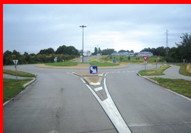
Carrefour giratoire de Saint-Pierre-la-Cour. Structure BC5g sur GB3, réalisée en 2005.
