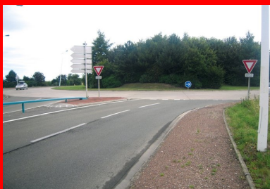
Carrefour giratoire Euro Chanel à Neuville-Lès-Dieppe (RD925). Structure BCig sur couche de forme, réalisée en 1995.
