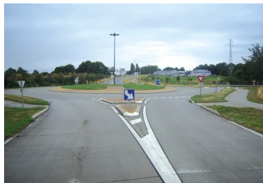
Carrefour giratoire de Saint-Pierre-la-Cour. Structure BCSg sur GB3, réalisée en 2005.
