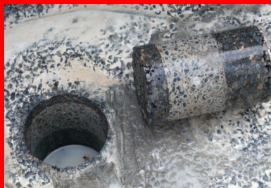
Carotte prélevée dans une chaussée composite illustrant parfaitement le collage BAC sur GB3.
