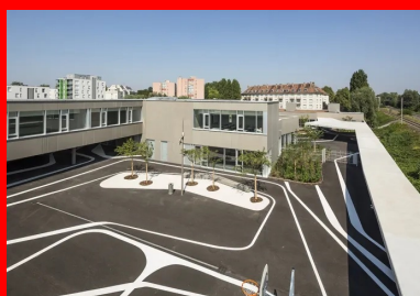
Les cours de récréation (ici, celle de l'école élémentaire) sont protégés des nuisances de voies ferrées par un mur écran.
