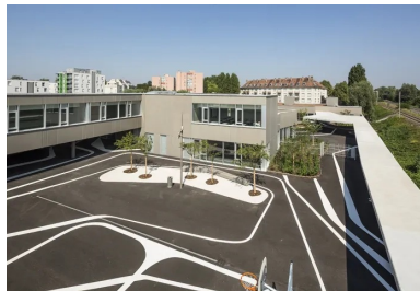
Les cours de récréation (ici, celle de l'école élémentaire) sont protégées des nuisances de voies ferrées par un mur écran.
