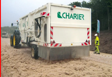
Épandage de la fibre de chanvre à l'aide d'un matériel spécifique.
