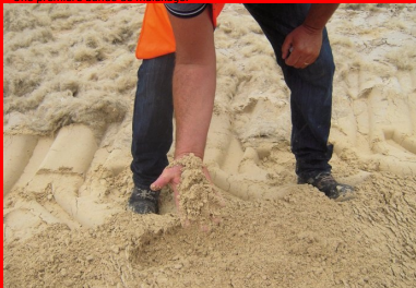
Aspect homogène du matériau après malaxage.
