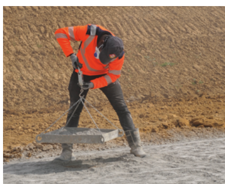
▲ Contrôle de l'épandage par pesée de bêche.
