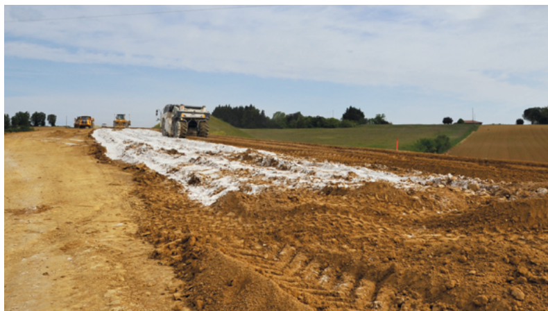
▲ L'arroseuse à enfouissement garantit une teneur en eau optimale.
