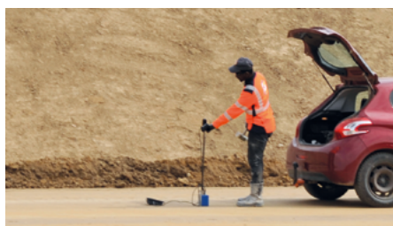
▲ Contrôle du compactage au PANDA
