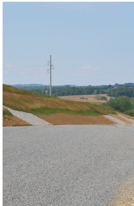
▲ Un enduit monocouche prégravillonné a été appliqué pour protéger la couche de forme et assurer une bonne prise hydraulique du mélange.
