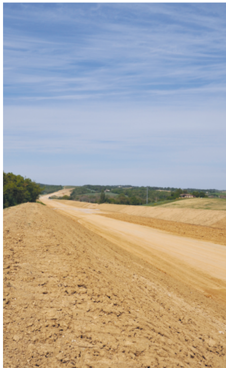
▲ Vue du chantier.
