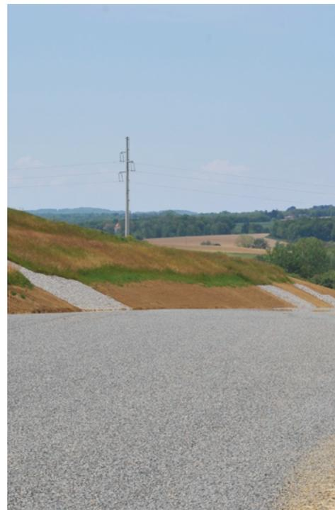
▲ Un enduit monocouche prégravillonné a été appliqué pour protéger la couche de forme et assurer une bonne prise hydraulique du mélange.
