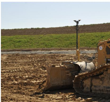
⤴ Pré réglage à l'aide d'un bull asservi GPS afin d'obtenir une épaisseur homogène avant traitement.
