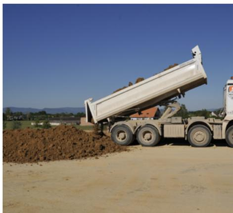
⤴ Acheminement des matériaux depuis le dépôt provisoire et mise en place sur le site pour une épaisseur finale de 35 cm.
