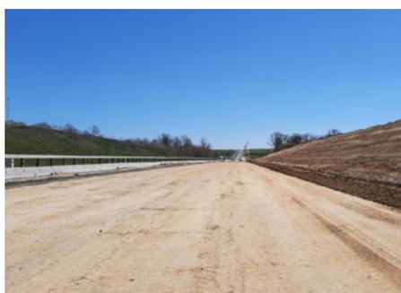
⤴ La liaison entre Toulon-Sur-Allier (Allier) et Digoin (Saône-et-Loire) fait appel massivement à la technique de traitement des sols en place au liant hydraulique routier LHR.
