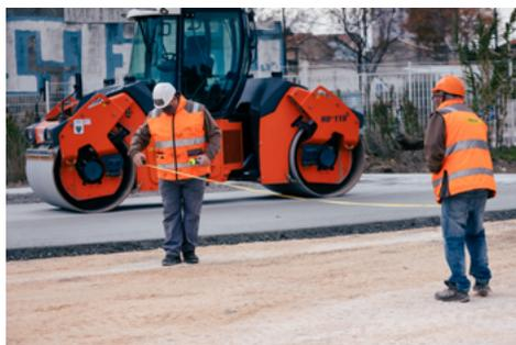
⤴ Pendant que la première couche de la première bande de BCR est compactée par un VT2, l'entreprise effectue les mesures pour positionner une nouvelle bande en respectant le plan de bétonnage en peigne. (© Béton Vicat)
