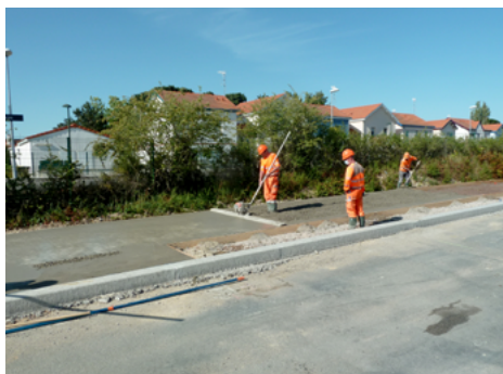
⤴ Vibration superficielle du béton.
