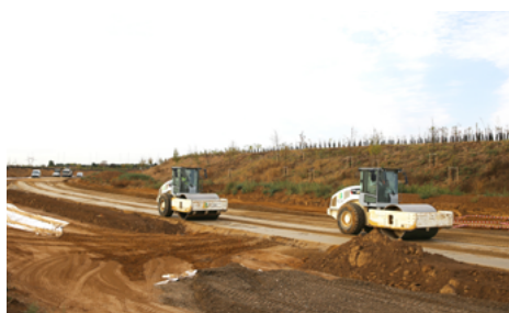
▲ Les deux compacteurs V5 de l'atelier de compactage.
