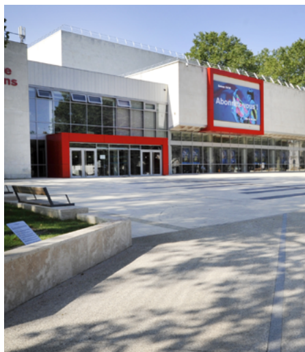
⤴ Le nouveau parvis en béton met en valeur la façade rénovée du théâtre. Conçue par le cabinet d'architecture Heudé et Heudé, elle est ornée de deux cubes rouges : l'un au niveau de l'entrée et l'autre accueillant un écran LED de 30 m 2 annonçant la programmation.
