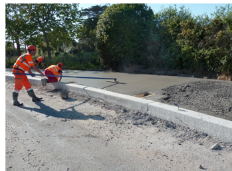
⤴ Talochage de la surface du béton.
