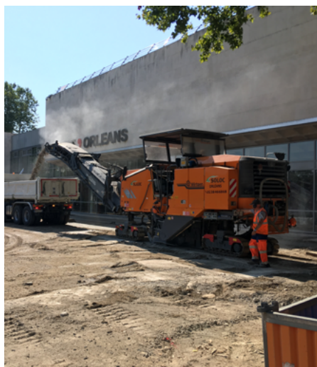
⤴ Travaux de démolition de l'ancien parvis et mise à nu du support.
