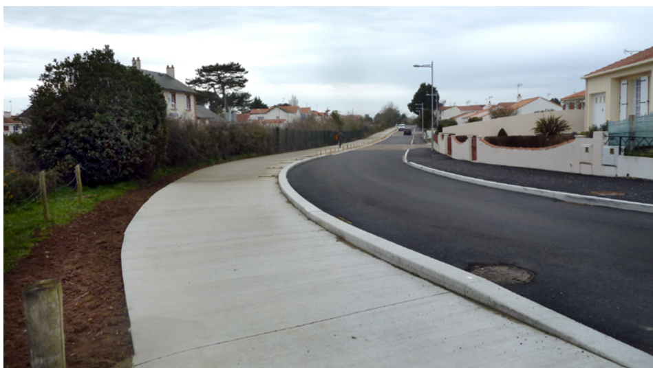
▲ Vue de l'avenue Gilbert-Burlot avec le nouveau revêtement de chaussée.
