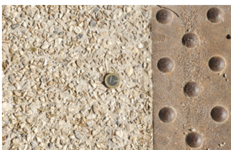
▲ Trois finitions de surface et trois colorations sont mises en œuvre sur le parvis : béton sablé sur durcisseur charbon Viasol avec charge scintillante (quartz) pour les bandes sombres, béton imprimé « Empreinte pierre » sur durcisseur couleur sable pour l'effet « roche brute » et béton désactivé de couleur claire.
