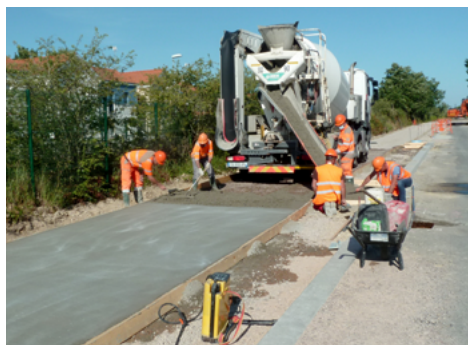
⤴ Coulage du béton.
