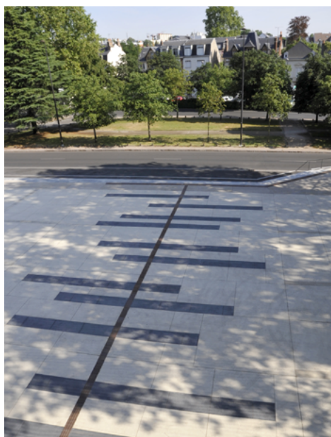
▲ Trois finitions de surface et trois colorations sont mises en œuvre sur le parvis : béton sablé sur durcisseur charbon Viasol avec charge scintillante (quartz) pour les bandes sombres, béton imprimé « Empreinte pierre » sur durcisseur couleur sable pour l'effet « roche brute » et béton désactivé de couleur claire.
