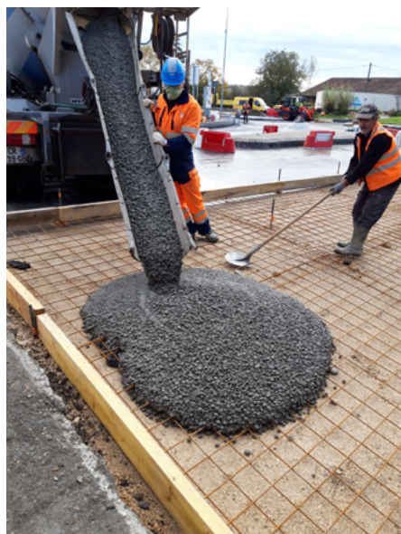
⤴ Réalisation des dalles de transition.
