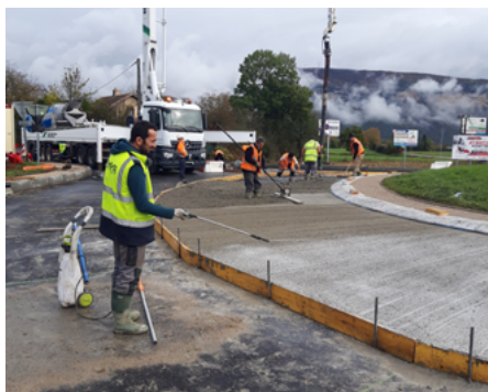
⤴ La protection du béton a été assurée par un produit de cure qui a été pulvérisé immédiatement après le traitement de surface.
