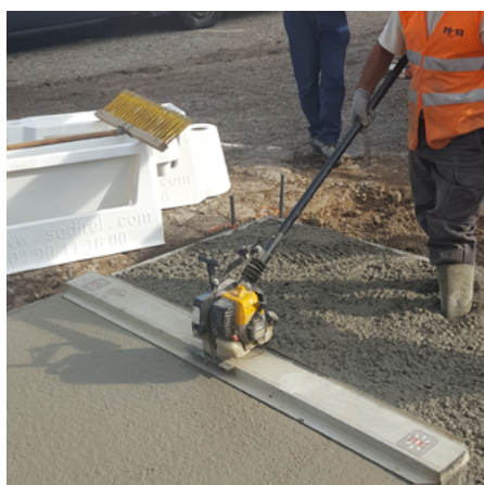
↑ Le béton pompé a été réparti et étalé manuellement, puis vibré à la règle vibrante pour assurer son bon serrage.
