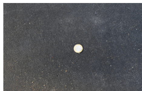
▲ Trois finitions de surface et trois colorations sont mises en œuvre sur le parvis : béton sablé sur durcisseur charbon Viasol avec charge scintillante (quartz) pour les bandes sombres, béton imprimé « Empreinte pierre » sur durcisseur couleur sable pour l'effet « roche brute » et béton désactivé de couleur claire.
