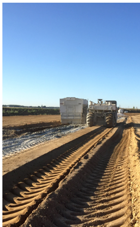
▲ L'épandage du liant hydraulique routier ROC VDS d'EQIOM à raison de 4,75 % (soit plus de 29 kg/m 2 ).
