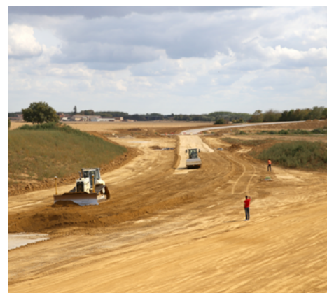
▲ Réglage et compactage.
