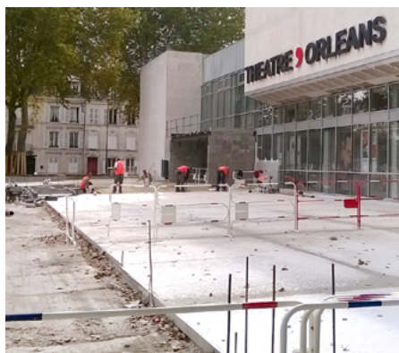
▲ Vue générale du chantier de mise en œuvre des bétons.
