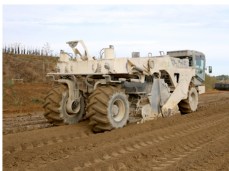
▲ Le malaxage a été effectué à l'aide de la stabilisatrice Wirtgen 2400. Pour s'assurer de la bonne interface PST-CDF, 1-2 cm du traitement de la PST ont été systématiquement repris.
