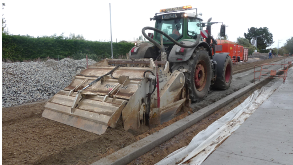
▲ Après épandage du liant, le malaxeur mélange intimement le liant et les matériaux de l'ancienne chaussée.
