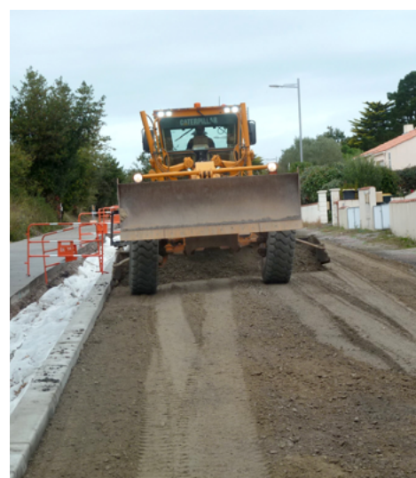
▲ Réglage du matériau retraité à la niveleuse.
