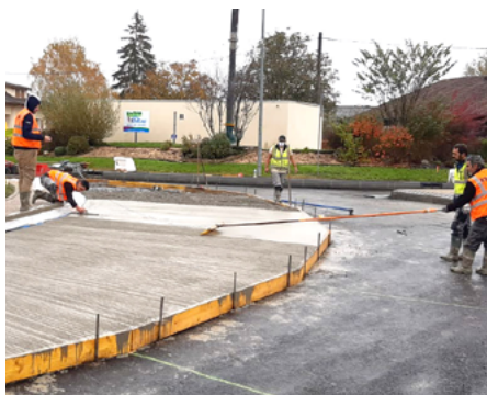
⤴ Le balayage, une étape cruciale pour obtenir une bonne PMT, gage d'adhérence sur le long terme pour les véhicules.
