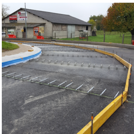
↑ Après l'homogénéisation de la fondation en GB, l'entreprise a procédé à l'installation des coffrages et des paniers de goujons, conformément au plan de calepinage.
