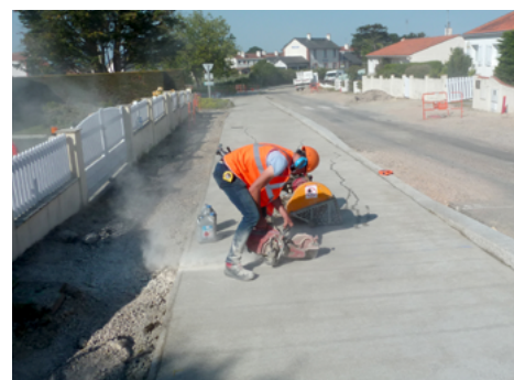
⤴ Exécution des joints de retrait par sciage.
