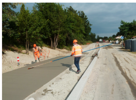
⤴ Balayage transversal du béton.
