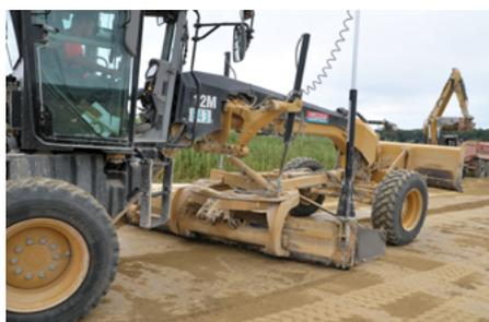
⤴ Un préréglage a été effectué à la niveleuse asservie GPS de façon à obtenir une épaisseur homogène préalable.
