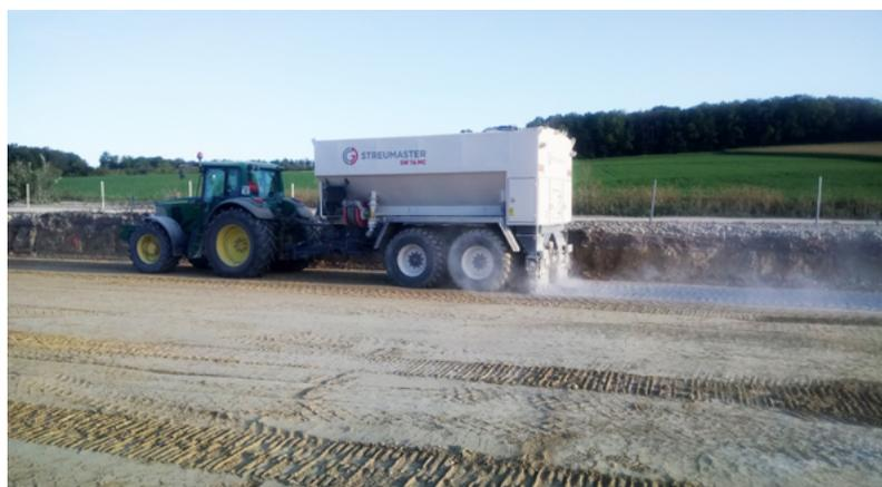
⤴ Le liant est épandu pour atteindre l'objectif d'un dosage de 5 %, avec vérification de la quantité épandue à l'essai à la bêche.
