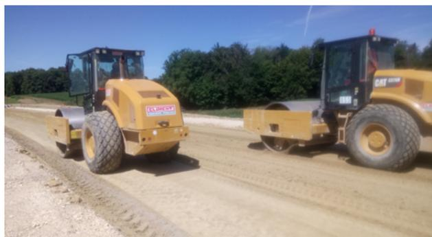
⤴ Un compactage partiel est effectué par deux compacteurs V5.
