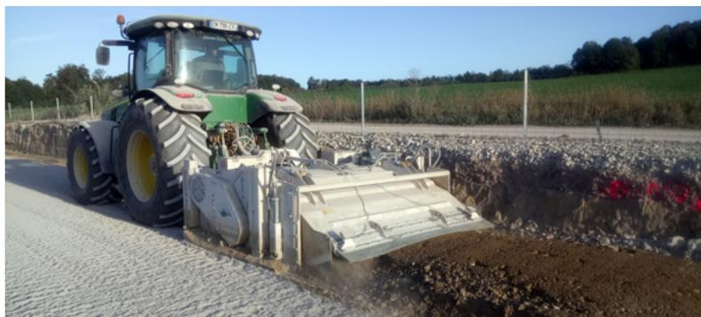
⤴ Le malaxage de la première couche est effectué avec un pulvimixeur de l'entreprise Brunner, sur une profondeur de 30 cm et une largeur de 1,80 m. Il nécessite trois passes complètes.
