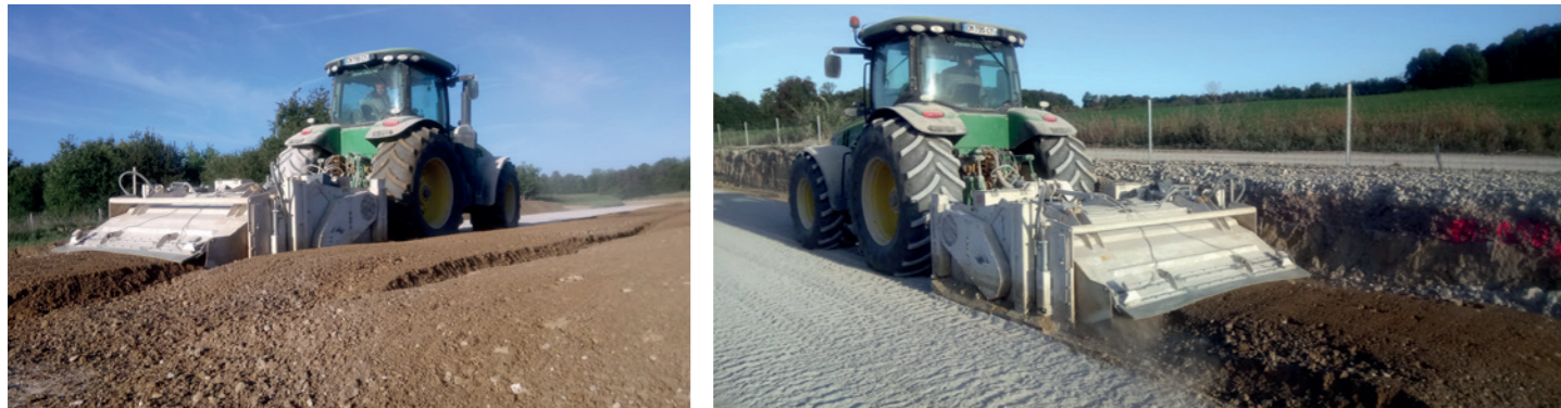
⤴ Le malaxage de la première couche est effectué avec un pulvimixeur de l'entreprise Brunner, sur une profondeur de 30 cm et une largeur de 1,80 m. Il nécessite trois passes complètes.
