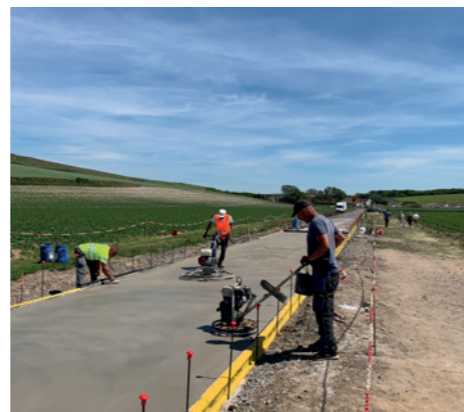
▲ Deux lisseuses mécanisées (hélicoptères) achèvent le lissage fin.
