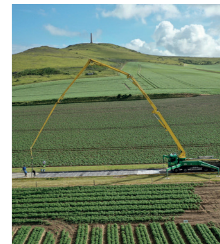
▲ Coulage du béton sur la rue de la Mer avec vue sur le cap Blanc-Nez et l'obélisque à la mémoire de la Dover Patrol. Le débettement de la pompe limite le coulage à des sections de 60 mètres par jour (environ 270 m 2 , soit la capacité de six ou sept toupies).
