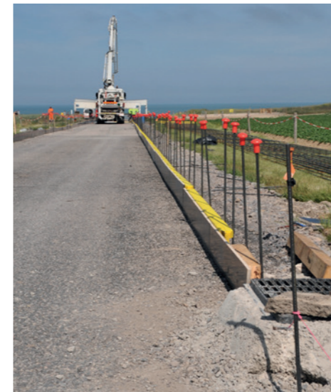
▲ Préparation de la plate-forme support : purge, reprofilage, travaux d'assainissement, compactage et enduit superficiel.
