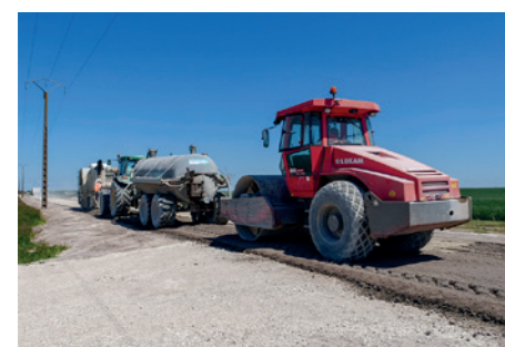
↑ L'atelier de malaxage est suivi d'un compacteur V4 qui assure un compactage léger permettant de refermer le matériau.
