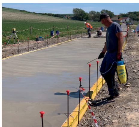
▲ Pulvérisation d'un produit de cure à la surface du béton frais pour le protéger de la dessiccation.
