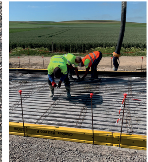
▲ Après avoir posé les armatures longitudinales sur les distanciers, l'équipe les ligature avec un recouvrement de 64 cm.
