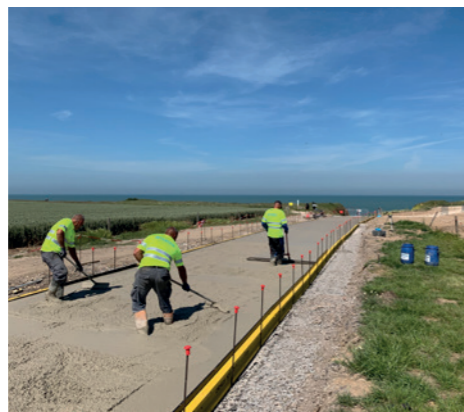
▲ L'étalage du béton s'effectue à l'aide de différents outils : rateau, épandeur ou lissarde.
