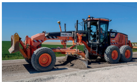
▲ La niveleuse intervient après le V4 pour mettre au profil la surface du matériau.
