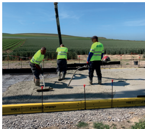
▲ Bétonnage : alimentation du béton à la pompe, réglage au rateau, suivi du serrage du béton à l'aiguille vibrante.
