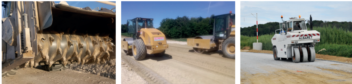
⤴ Vue du rotovator du pulvimixeur de l'entreprise Brunner.
