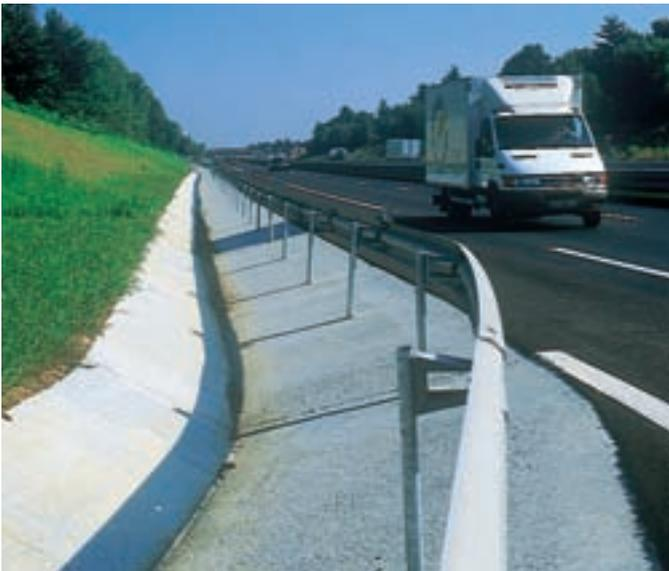
*Les ouvrages hydrauliques en béton permettent de respecter la loi sur l'eau et son obligation de recueillir puis de filtrer les eaux de ruissellement avant de les rejeter dans l'environnement.*
