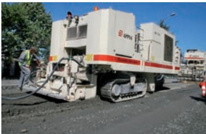
*Le retraitement des chaussées en place au ciment ou aux liants hydrauliques routiers épargne les ressources en granulats et supprime les nuisances dues à leur transport.*
