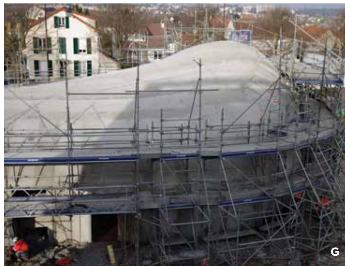
G ___ L'ensemble de la coque, en béton armé de 20 cm d'épaisseur, est finie manuellement à la taloche.
