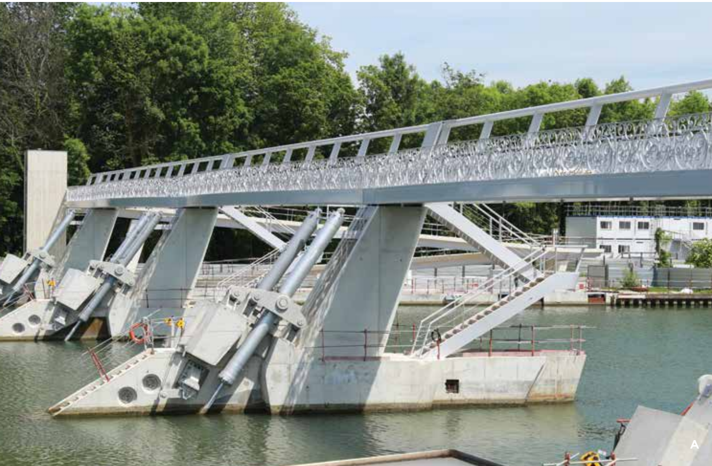
A __ Vue du nouveau barrage de Vives-Eaux et de la passerelle accessible au public.
