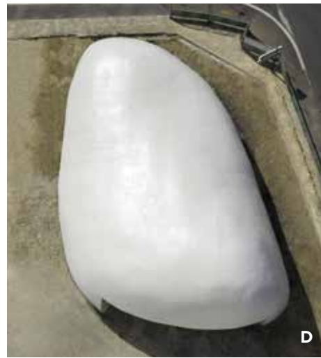
C ___ Prémurs arrondis en béton, d'une hauteur de 8 m épousant la coque en béton.
