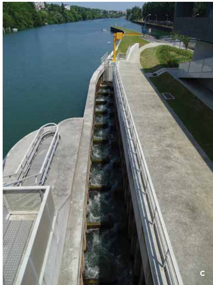
B, C __ Passes à poissons à chambres successives dans les barrages de Vives-Eaux (B) et Chatou (C).
