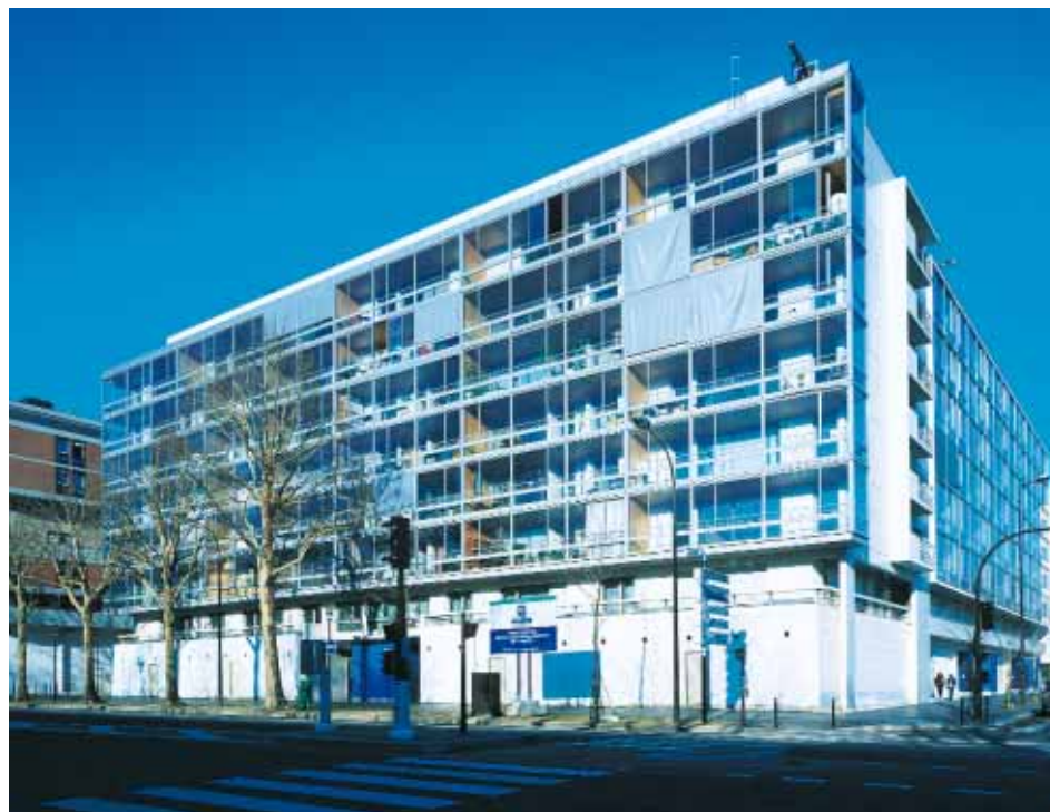
▲ Sur le boulevard Mac-Donald et le côté est de l'îlot, les deux immeubles forment écran.
