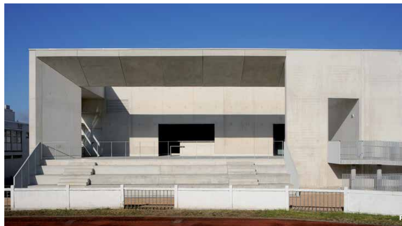
E ___ La casquette installée sur la façade arrière, côté buvette, fait écho à celle marquant l'entrée principale dans le gymnase.
