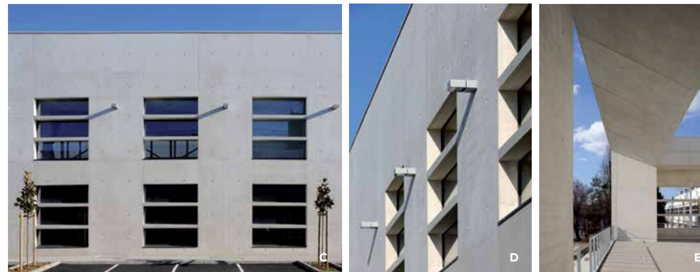
C, D ___ Façade sud, des brise-soleil en béton préfabriqués protègent les ouvertures du rayonnement tout en participant à leur redécoupage.
